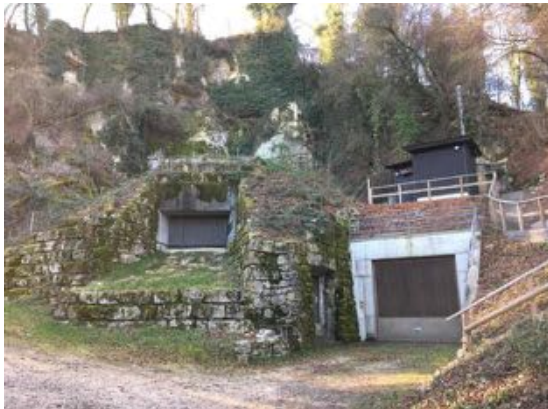
Aussenansicht der Festung Rein. Vorne links der Centurionbunker, rechts davon die Garageinfahrt P26.
